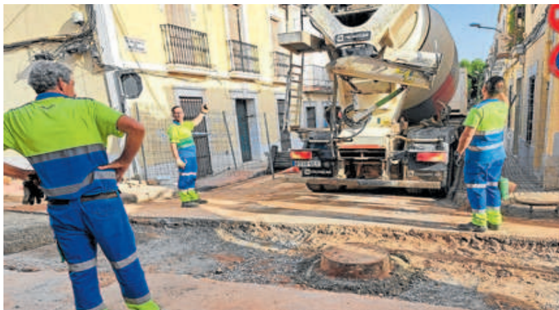
Operarios de Aqualia durante los cambios de tubería en la calle de Pontezuelas y su travesía. HOY
